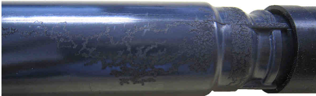
消耗したプラグによるリーク事例
